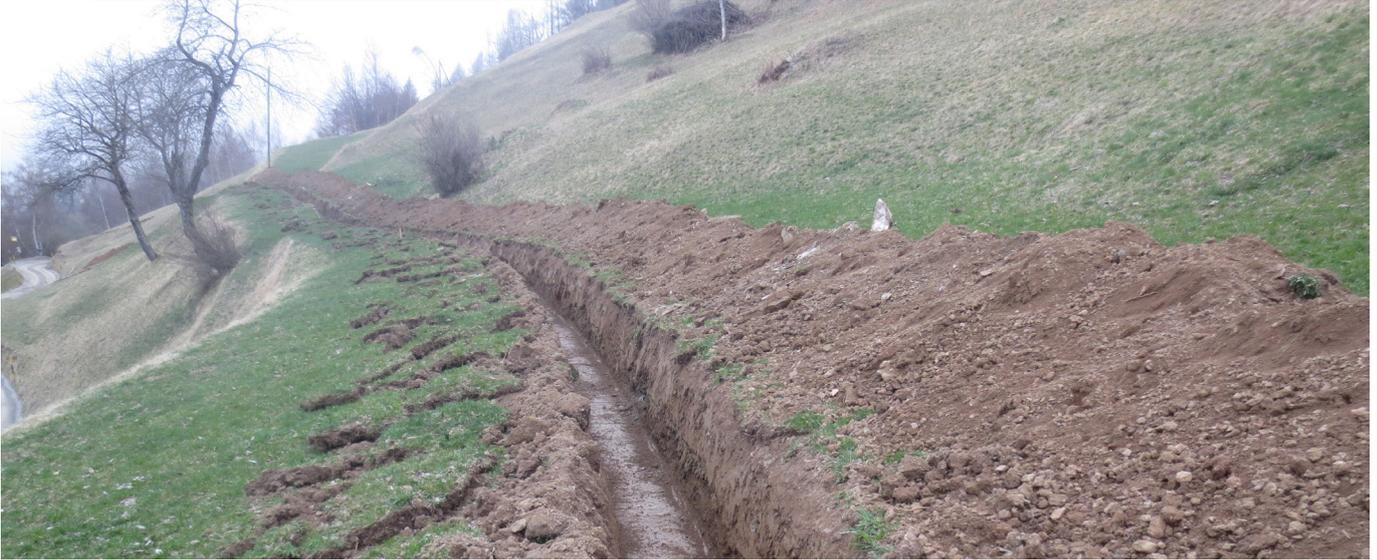
In Trans, eine Fraktion der Gemeinde Domleschg, wurde die oberirdisch geführte Freileitung nach Meunt in den Untergrund verlegt. Die neue Leitungsführung verläuft in einem Gebiet mit schützenswerten Trockenwiesen und -weiden (TWW) von nationaler Bedeutung.
